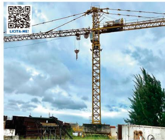
Grua Torre POTAIN H3 28 Lança 60m · Altura 34m
