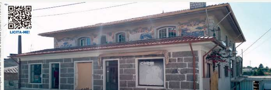
EDIFÍCIO EM PEDRA (LOJA · ARMAZÉM · HABITAÇÃO) RUIVÃES, VILA NOVA DE FAMALICÃO
