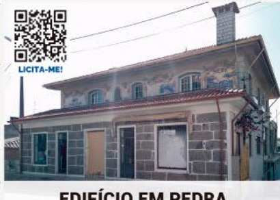
EDIFÍCIO EM PEDRA (LOJA · ARMAZÉM · HABITAÇÃO) RUIVÃES, V. N. DE FAMALICÃO
