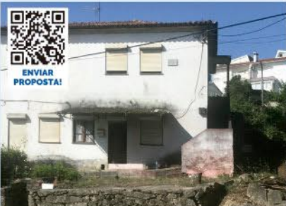
MORADIA COM LOGRADOURO SÃO JOÃO DA MADEIRA
