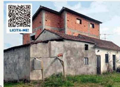
MORADIA V3 EM CONSTRUÇÃO ALVAIÁZERE
