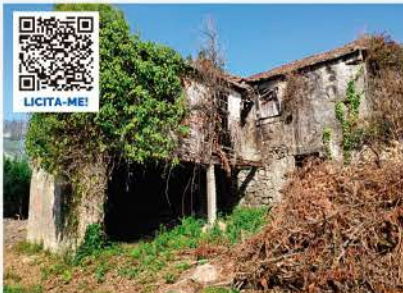
MORADIA P/ RECONSTRUÇÃO MANSORES, AROUCA
