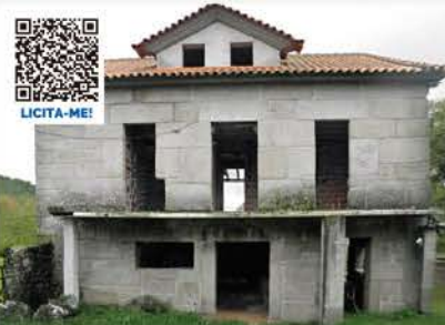
MORADIA V3+1 EM CONSTRUÇÃO BEIJOS, CARREGAL DO SAL
