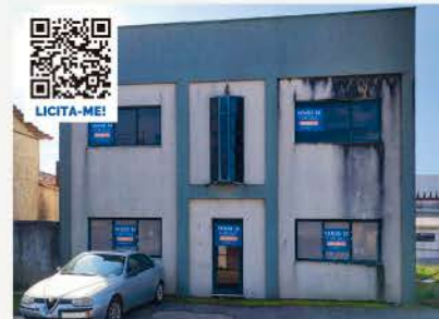
ARMAZÉM INDUSTRIAL SILVALDE, ESPINHO
