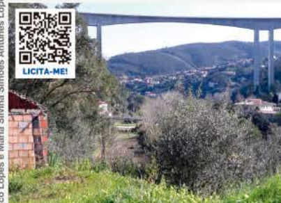
LOTE PARA CONSTRUÇÃO CEIRA, COIMBRA
