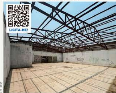
INSTALAÇÃO COMERCIAL KILAMBA KIAZI, LUANDA
