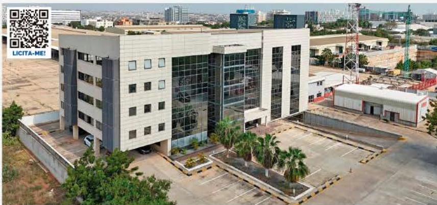
UNIDADE INDUSTRIAL (Edifício GEFI) TALATONA, LUANDA
