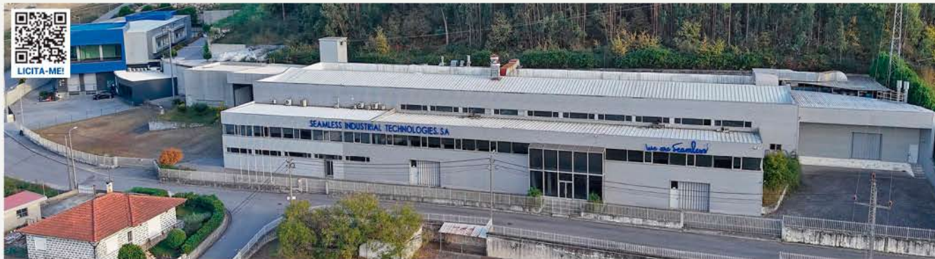
ARMAZÉM INDUSTRIAL (3 Pisos) · VILA NOVA DE FAMALICÃO
