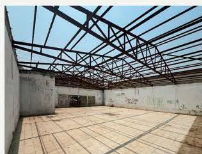
INSTALAÇÃO COMERCIAL PALANCA, KIMBANGO
