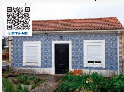
MORADIA COM QUINTAL ESGUEIRA, AVEIRO
