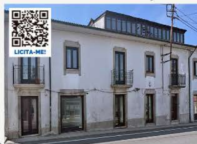
EDIFÍCIO (2 Pisos) DARQUE, VIANA DO CASTELO
