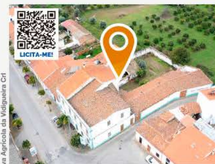
EDIFÍCIO (2 Pisos) · VIDIGUEIRA
