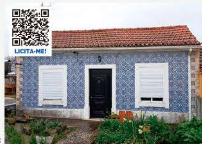
MORADIA COM QUINTAL ESGUEIRA, AVEIRO
