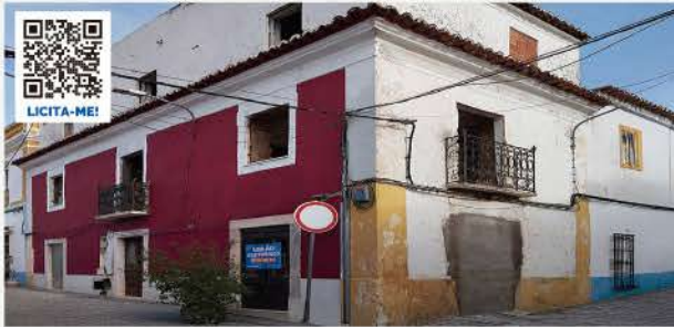
EDIFÍCIO PARA RENOVAÇÃO · ELVAS
