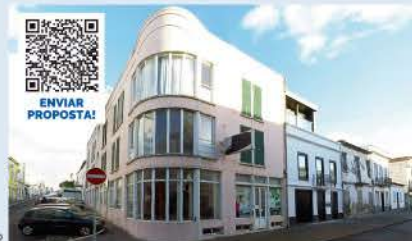
EDIFÍCIO (5 Pisos) SÃO PEDRO, PONTA DELGADA
